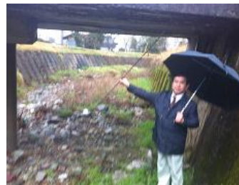
秋芳町の河川現場 老朽化した橋の補修
