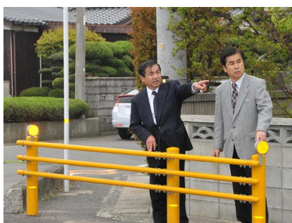
歩道用ガードレールが設置されました（JR長門長沢駅付近）
