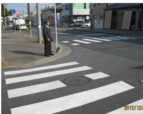
南浜町1丁目付近の横断歩道にラインの引き直し工事が完了しました
